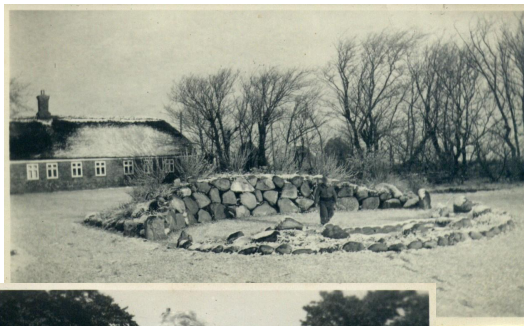
Sønnen Ib i nyanlagt stensætning
